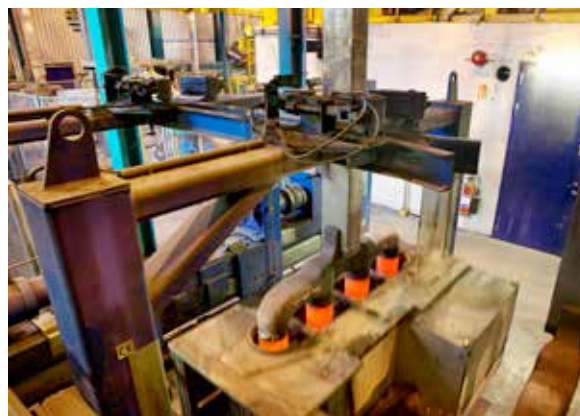
Sin polvo, sin humos, sin ruidos. Un equipo de calentamiento EFD Induction consigue pre calentar simultáneamente cuatro barras de ánodo de 170 mm de diámetro.
