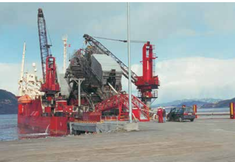
EFD Induction trabajando en el Mar del Norte. La fotografía muestra un buque instalador de tuberías que lleva un equipo de inducción EFD Induction para tratamiento térmico post-soldadura.
