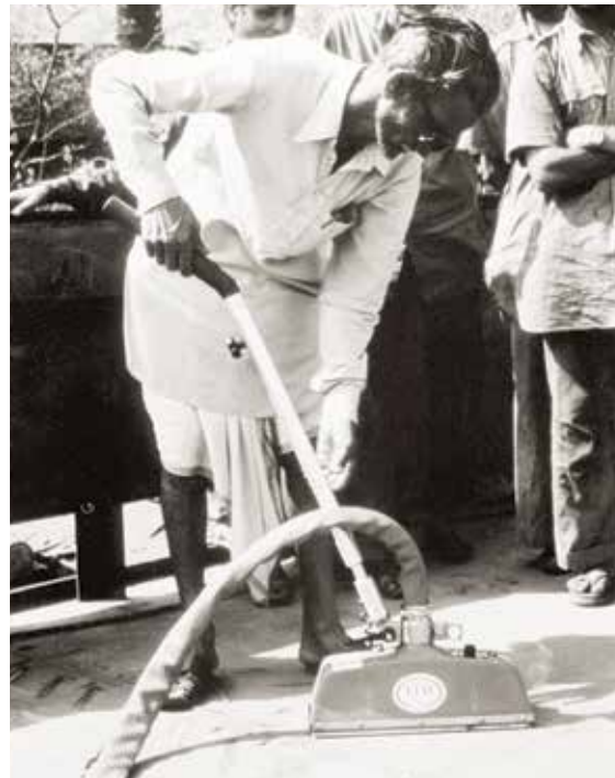
Die Produkte von EFD Induction werden seit Jahrzehnten weltweit eingesetzt und genießen das Vertrauen ihrer Kunden. Dieser Schnappschuss zeigt Mitarbeiter der Garden Reach Shipbuilders and Engineers Ltd. in Calcutta, Indien, wie sie ihre neue Induktionserwärmungsanlage ELVA TERAC 16 prüfen. Das System wurde zum Richten von Schiffsrümpfen verwendet.
