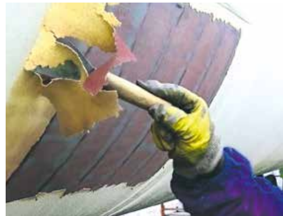
Das Entschichtungssystem trägt industrielle Beschichtungen in fast jeder beliebigen Dicke ab.
