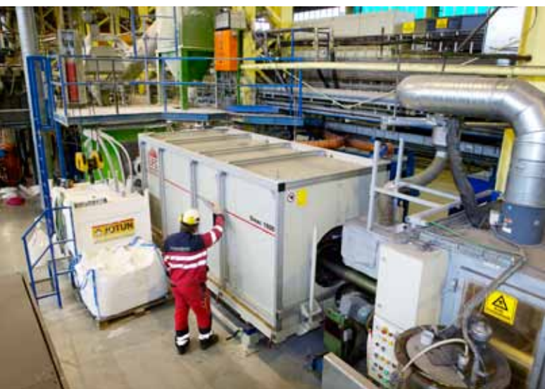
中频 EFD Induction Sinac 设备在加涂层前对海水应用管道进行预热。
