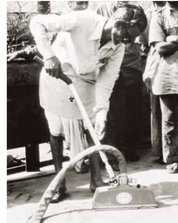
Los equipos de EFD Induction han sido utilizados durante décadas y siguen gozando de plena confianza en el ámbito mundial. Esta foto de 1986 muestra cómo los empleados de Garden Reach Shipbuilders and Engineers Ltd. en Calcuta, India, prueban su primera máquina de calentamiento por inducción ELVA TERAC 16. El sistema se usaba para enderezar cascos de buques.
